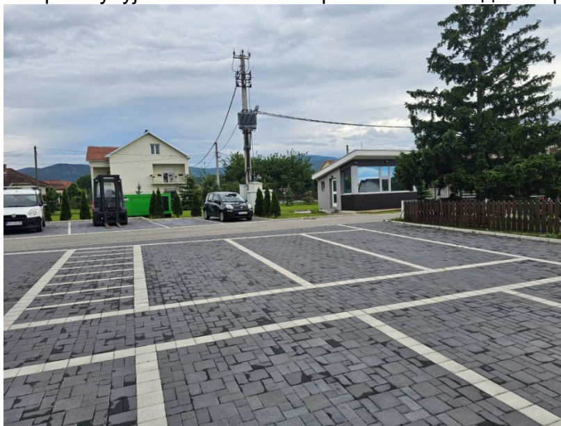
слика 13 постојећа ТС и агрегат
